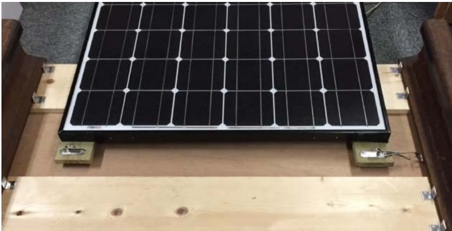
図 13.3 防腐剤注入した木材を絶縁材に使用した例
