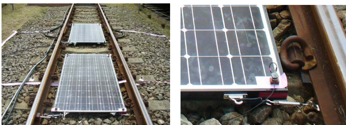
図 10.2 クッション材 20mm、直掛け（フック方式）のパネルの取付状況
