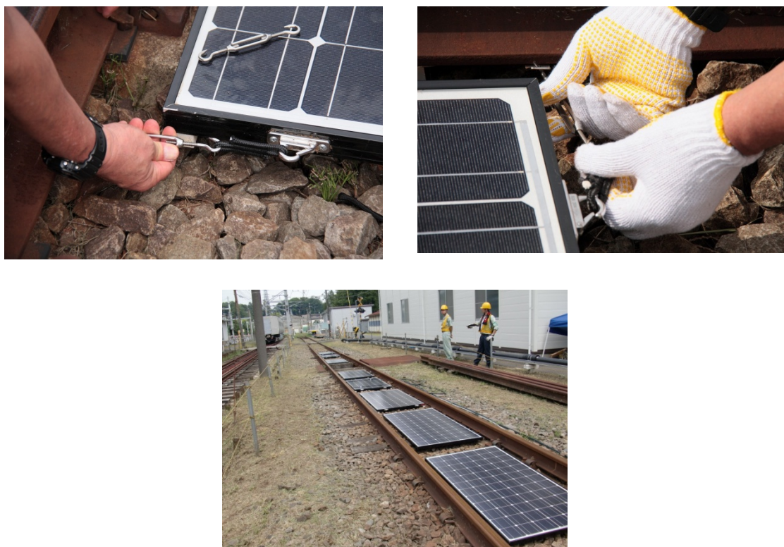
図 4.7 鉄道総研での脱着試験
