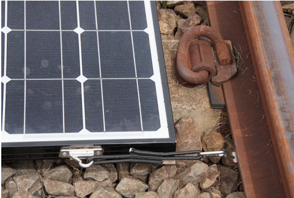
図 6.3 ハイテク絶縁ワイヤーの取付方法
